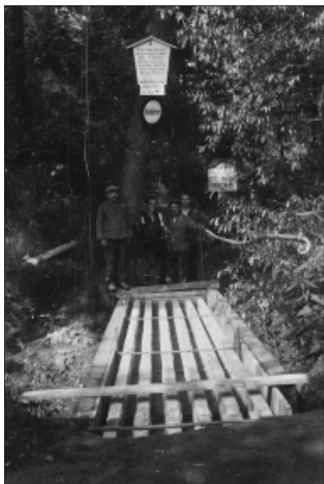
Wegebau im Zschonergrund, Foto 20er Jahre
