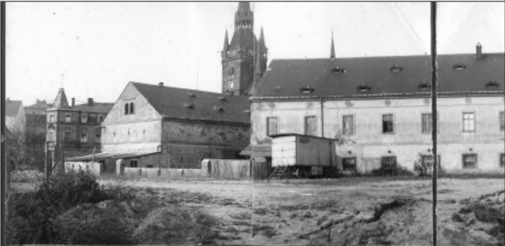
Dezember 1938. Dresden-Loschwitz, Franz II Hof G... Lageraufpfützung, möglicherweise Gornitzpark.
