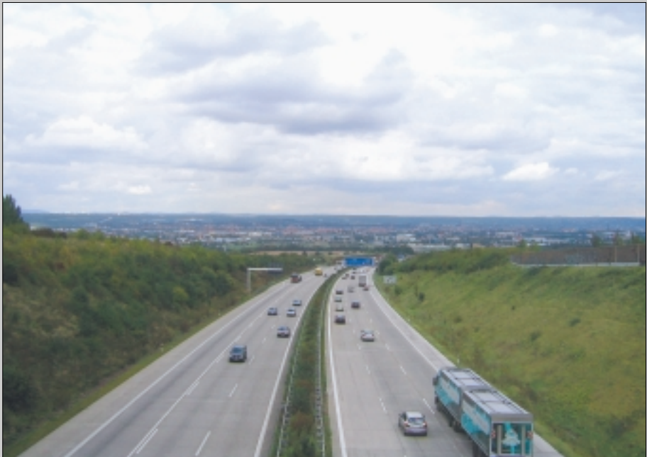
Blick von der Mobschatzer Autobahnbrücke auf die A17. Foto: Florian Weigelt, September 2007
