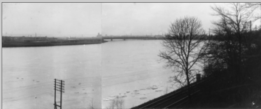
17. III 1940, Dresden - Briesnitz, Blick stadtwärts, Hochwasser 8,25 m.
