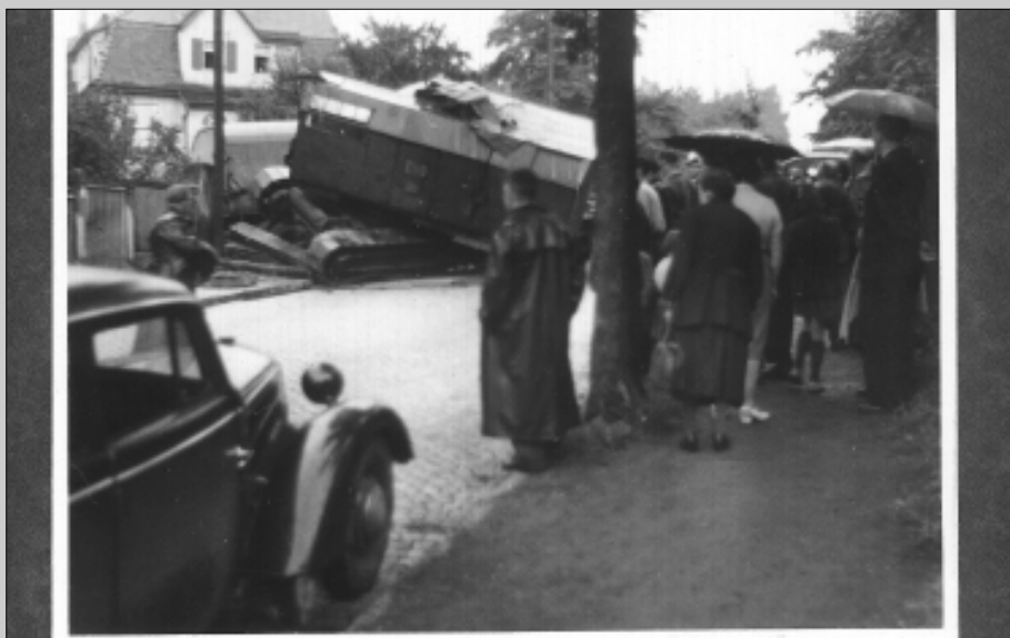
Dresden-Kemnitz, Am Kirchberg, Auto- bahn-Ausfahrt. Unfall vor dem Haus
