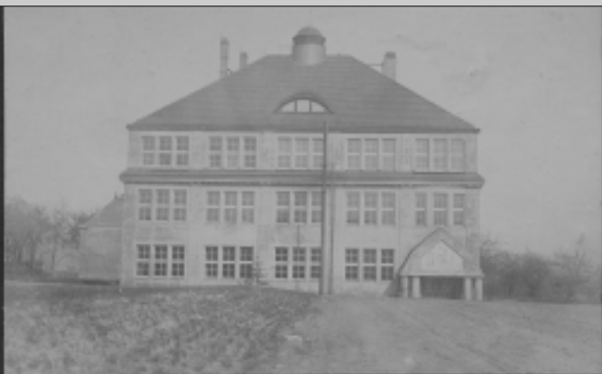
Neues Schulgebäude der Gemeinde Briesnitz i. J. 1914. Jetzige 75. V. Sch. Dresden.
