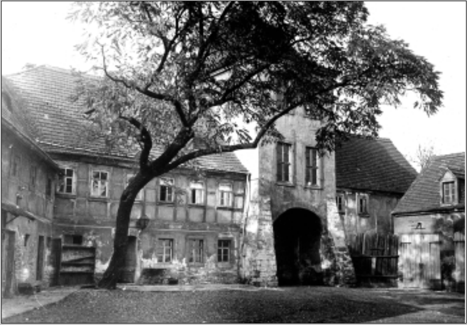
Das Bennogut 1937 – Innenansicht
